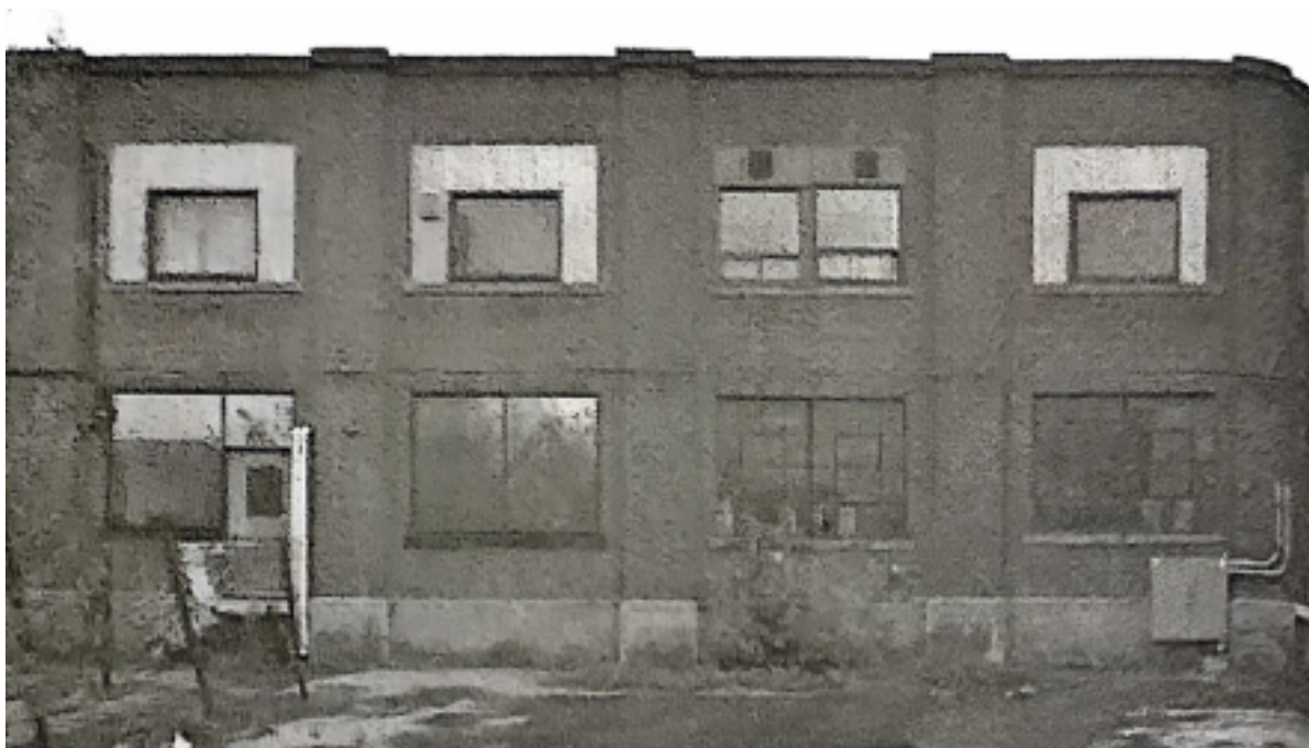
Bâtiment 7 — Élévation sud — Partie A ( à l'avant de l'immeuble ) Espace prévu pour le Centre social autogéré [Benoit Muylderman, 2009]
