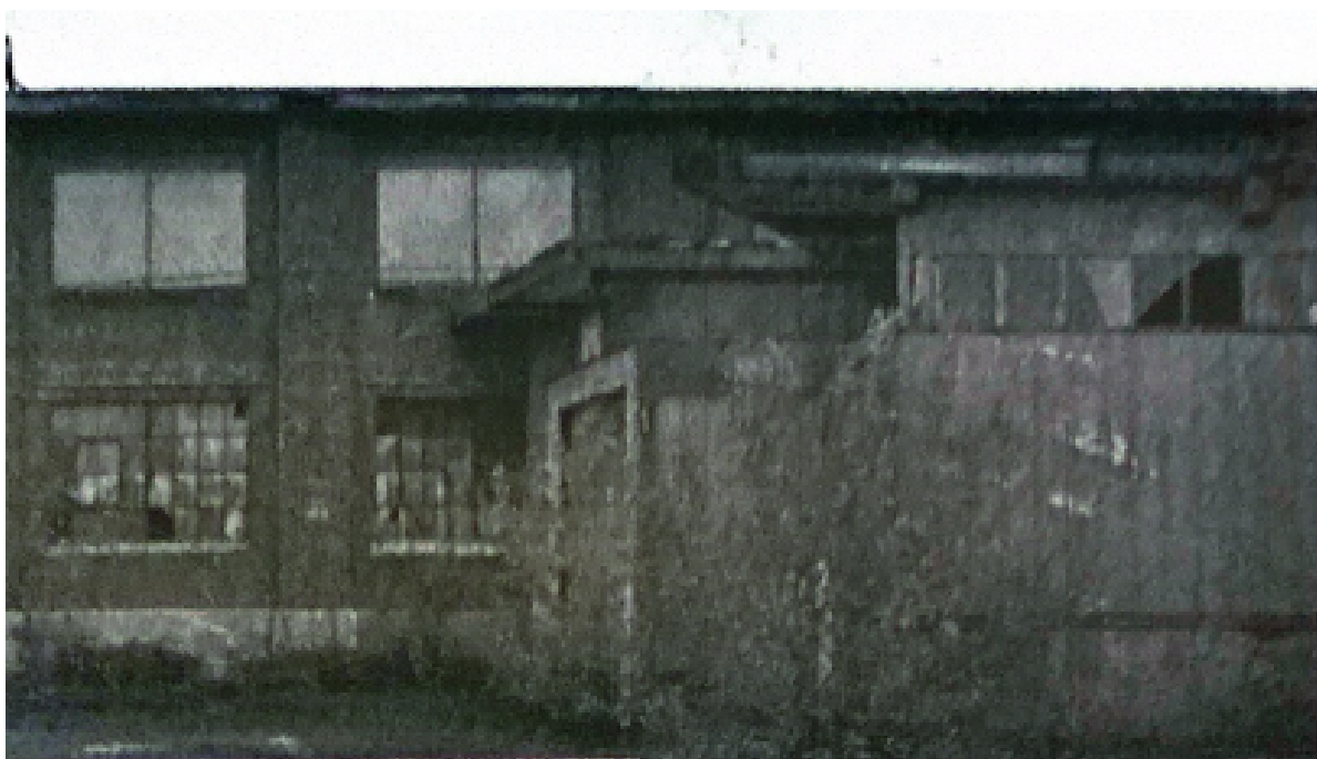
Bâtiment 7 — Élévation sud — Parties B3-B4 Espace prévu pour ateliers d'artistes (Fonderie Darling) [Benoit Muylderman, 2009]
