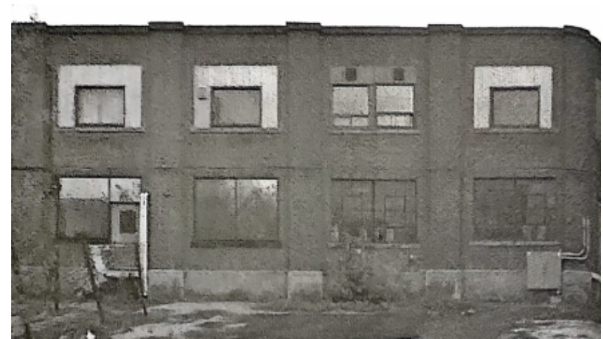
Bâtiment 7 — Élévation sud — Partie A (à l'avant de l'immeuble) Espace prévu pour le Centre social autogéré [Benoit Muylderman, 2009]
